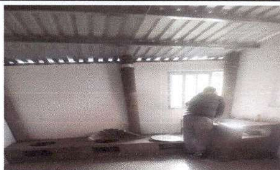
Foto 2: Sustitución de estufa rural completa, incluye chimenea y plancha de metal.
