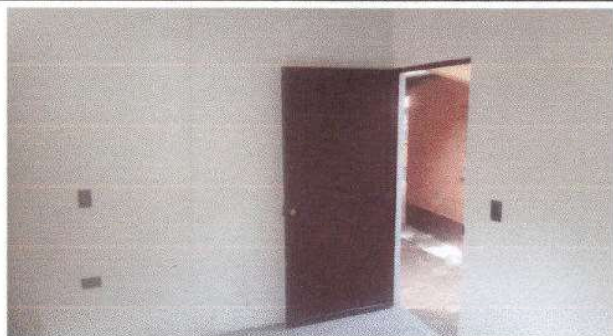
Foto 1: Sustitución de puertas de metal.
