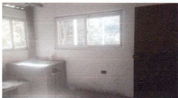
Foto 3: Sustitución de puertas de metal.
